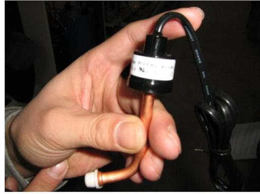
**Рис.28. Датчик низкого давления.**
